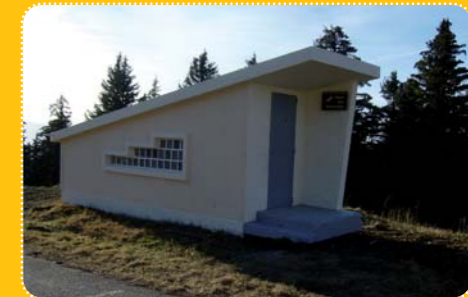
• WC publics Place des Niverolles à Recoign Réfection totale après plus de 20 ans de fermeture 14 500 €
