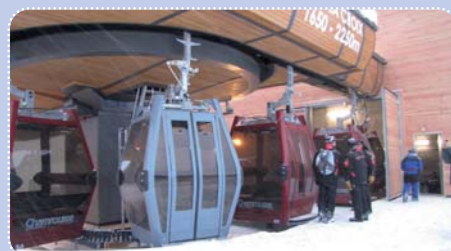
Gare amont et poste de secours
