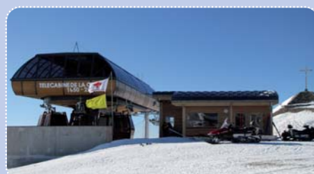
Gare amont et poste de secours
