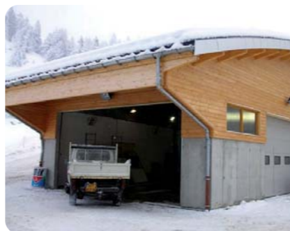
Extension du garage
